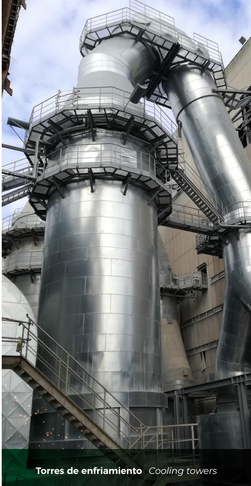
Intercambiadores aire-aire para enfriadores de clinker Air to air heat exchangers for clinker coolers
