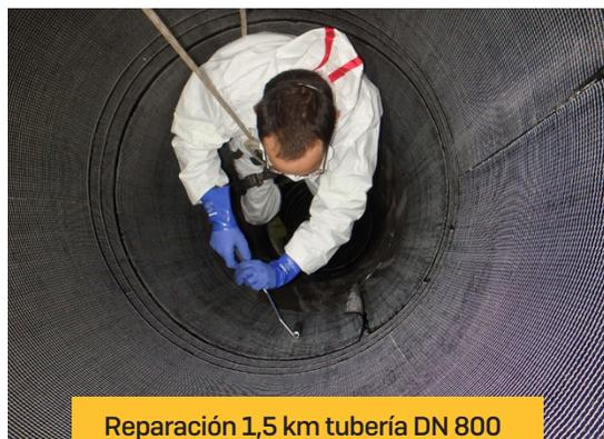
Reparación 1,5 km tubería DN 800 refrigeración reactor nuclear
