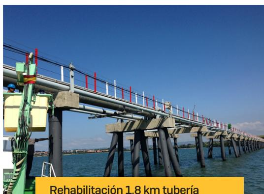
Rehabilitación 1,8 km tubería DN 600 en pantalán marítimo
